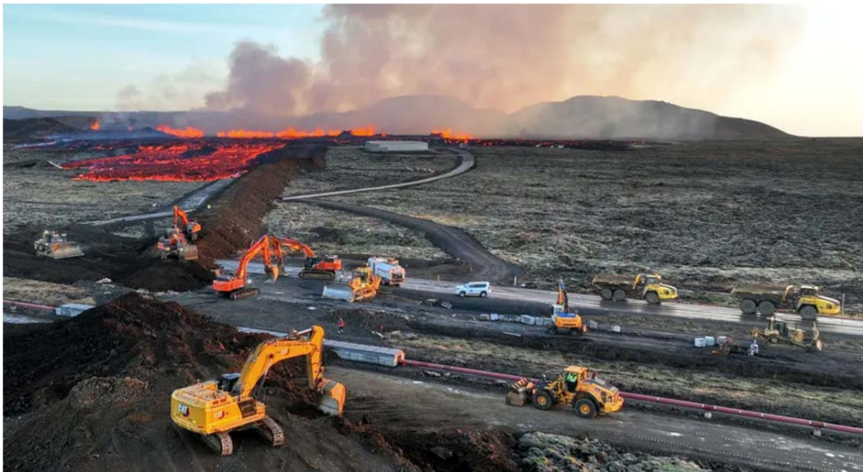
Figur 2: Vulkanudbrud i Island i 2024 samt konstruktion af dige, der skal forhindre lava i at overstrømme kraftvarmeværk.
